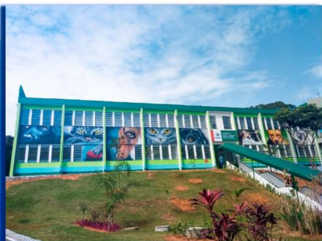
HOSPITAL VETERINÁRIO MARIZA HELENA BRAGA
